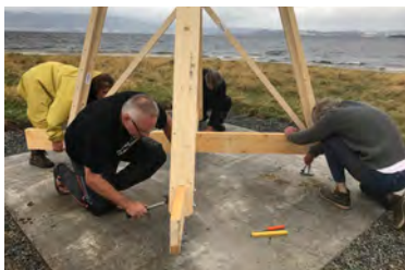
Byggearbeider for Wenches Mjøsblikk , juli 2018.
